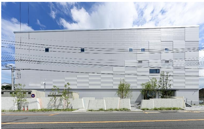
加須の伝統工芸品である鯉のぼりと利根川のきらめきを表現した外壁
