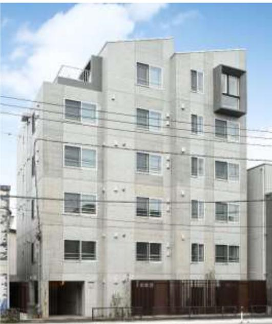
雁行形状と勾配屋根を持ち、木目のテクスチャーを織り交ぜた打ち放しコンクリートの外観
